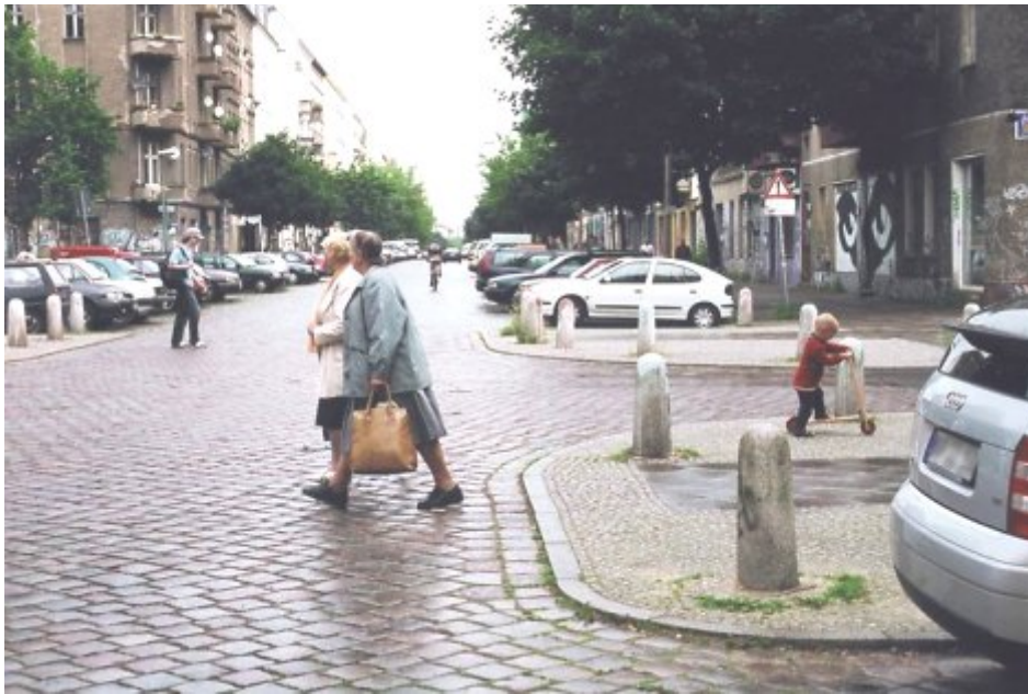
Abbildung 36: Gehwegvorstreckung in Berlin
