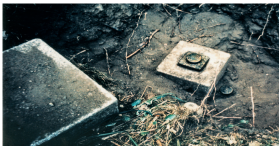
Abb. 7: eingesetzter Normal-Höhenpunkt
