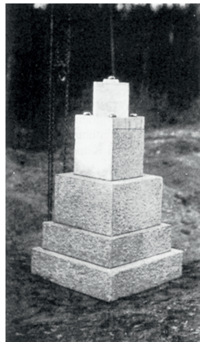
Abb. 6: unterirdische Festlegung des Normal-Höhenpunktes
