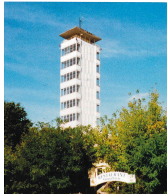
Der Muggelturm, zum Jahreswechsel 1960/61 fertiggestellt
