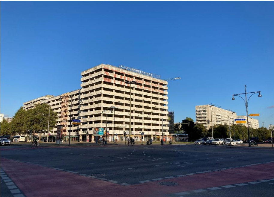
Abbildung 4 Blick auf den Gebäudekomplex Haus der Statistik | Quelle: F. Hutterer (SenSBW)
