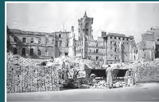
Beseitigung von Trümmern und Sicherung noch brauchbarer Ziegel in der Nähe des Rathauses, 1946 Removing the debris and salvaging still-useable bricks near the Rotes Rathaus, 1946
